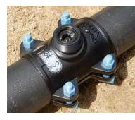
管路に残るものはサドルのみ
